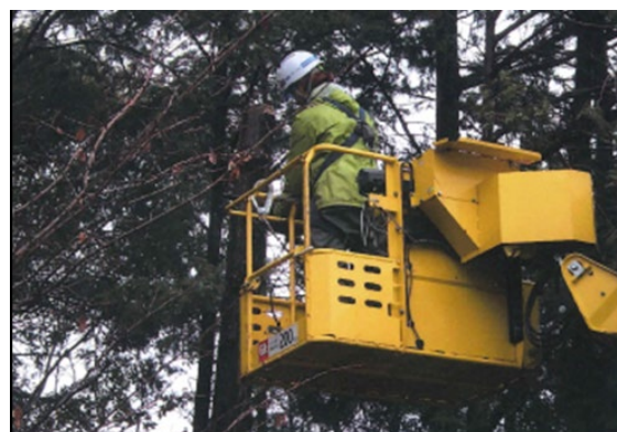
【支障樹木の伐採】
